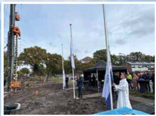
Nieuwbouw van 23 woningen in deelgebied C (wijk van de toekomst) van start
