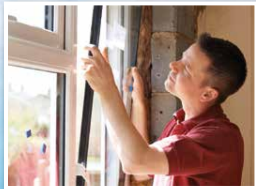
Enkel glas vervangen door dubbel glas (HR++ glas)
