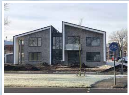
Oplevering nieuwbouw 10 appartementen Rolde
